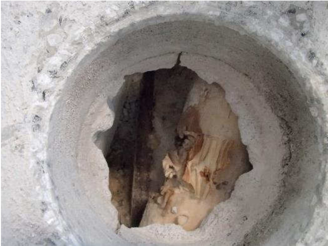
Kuva 62. Rakenneavaus 1.kerroksen käytävän alapohjaan.
