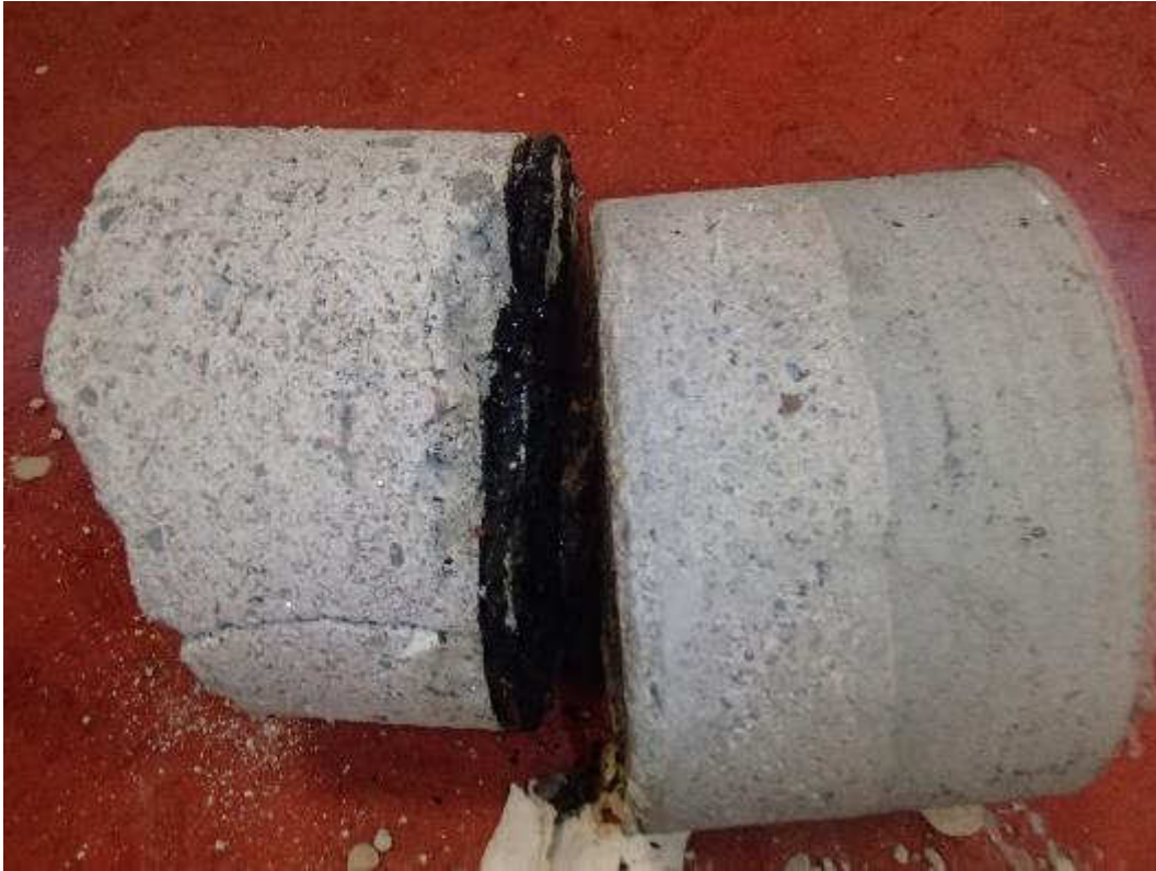
Kuva 42. Rakenneavaus esikoulun välipohjaan entisen suihkutilan kohdalta.
