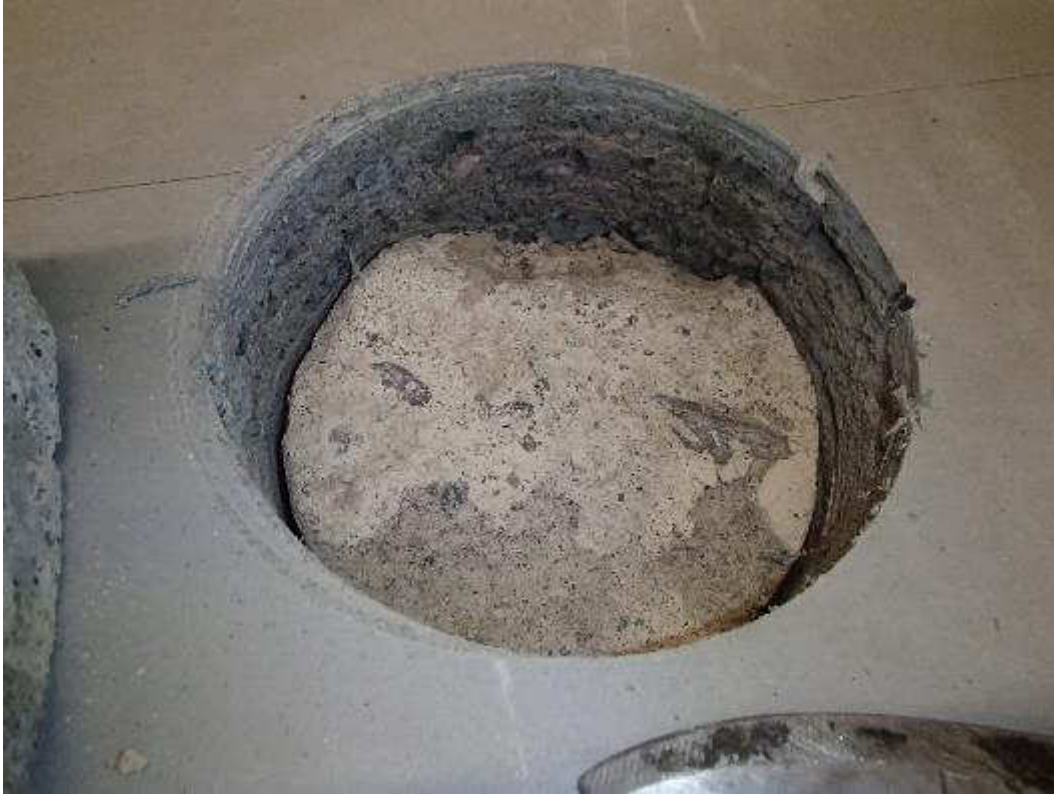
Kuva 48. Rakenneavaus terveydenhoitajan huoneen kohdalta välipohjaan.
