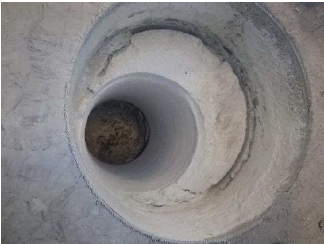
Kuva 61. Rakenneavaus alapohjaan luokkahuoneen keskiosalta.
