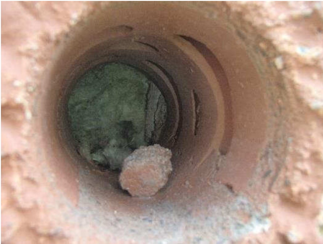
Kuva 75. Rakenneavaus ulkovaipparakenteeseen.
