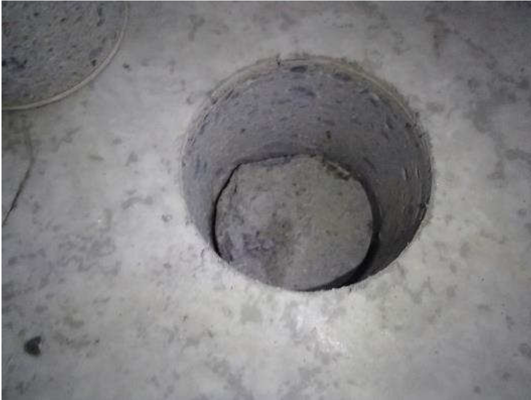
Kuva 109. Rakenneavaus alapohjarakenteeseen.
