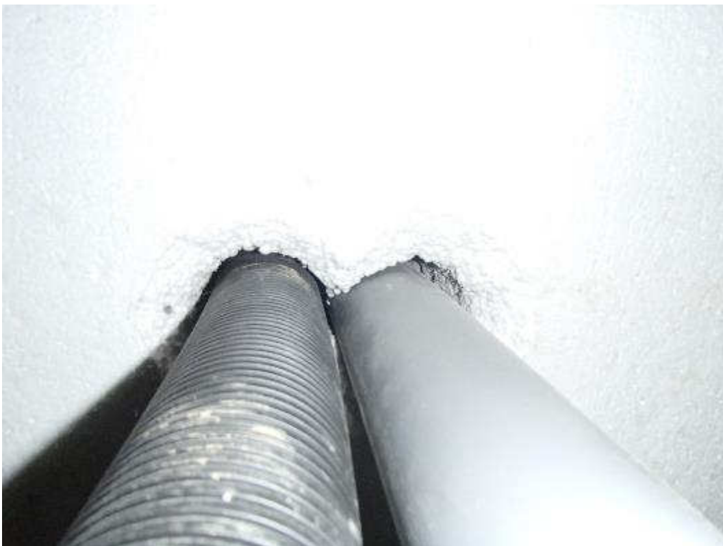
Kuva 122. Alapohjan läpiviennit eivät ole tiiviitä.
