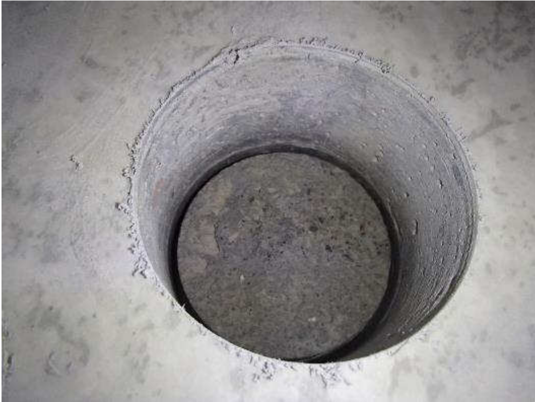
Kuva 110. Rakenneavaus välipohjarakenteeseen.
