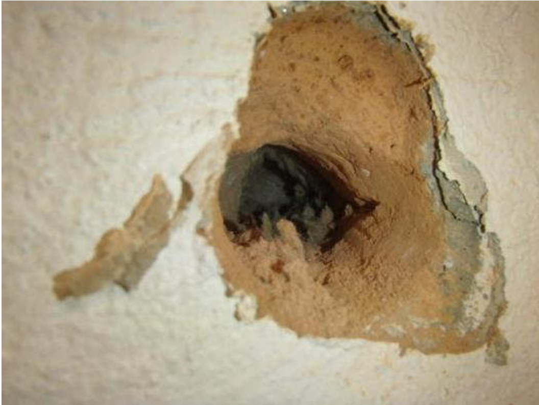
Kuva 63. Rakenneavaus maanvastaiseen seinään.
