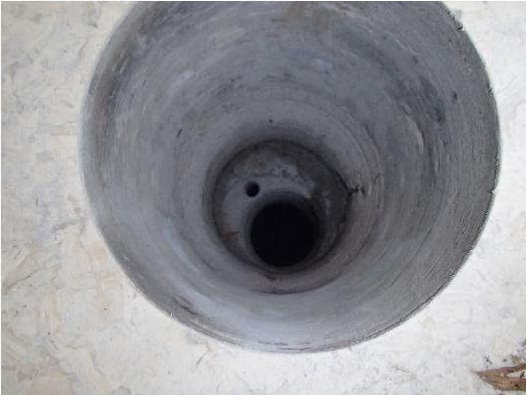
Kuva 59. Rakenneavaus esikoulun alapohjaan.
