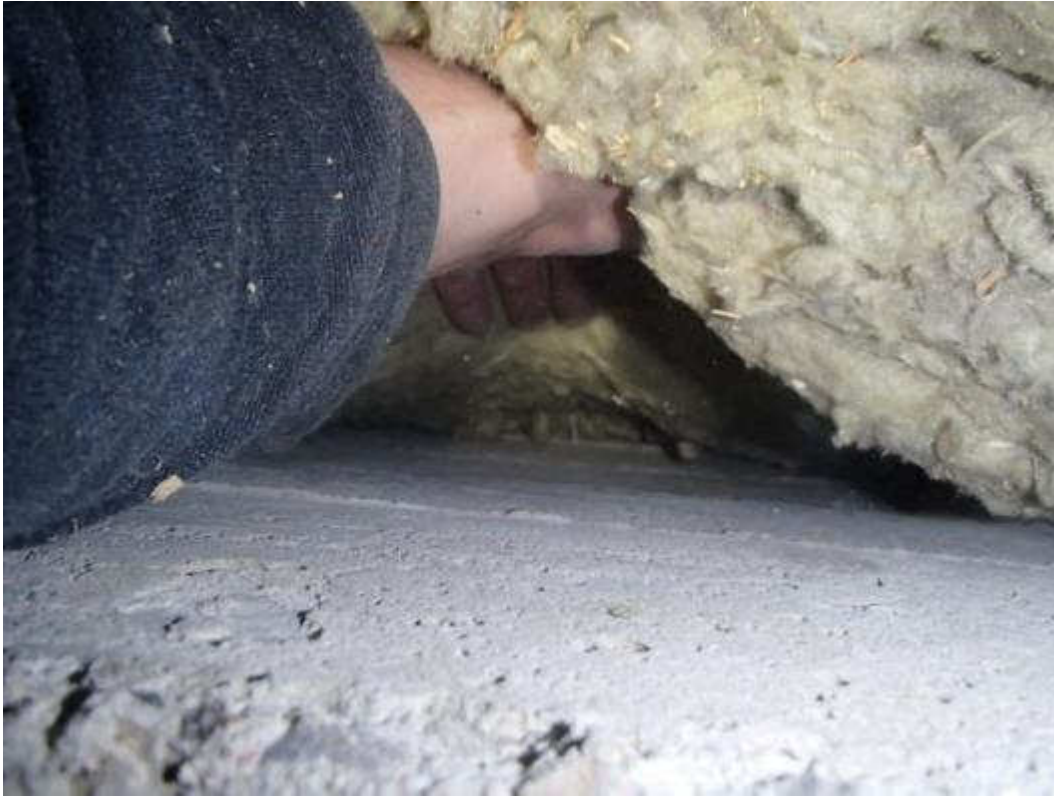
Kuva 107. Yläpohjan ja ulkovaipan sisärungon liitoskohdat olivat tarkastetuilta osin tiiviitä.
