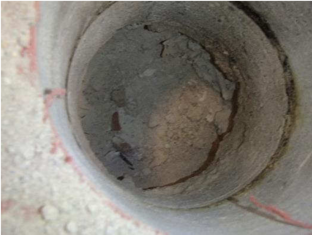
Kuva 41. Rakenneavaus esikoulun välipohjaan entisen suihkutilan kohdalta.
