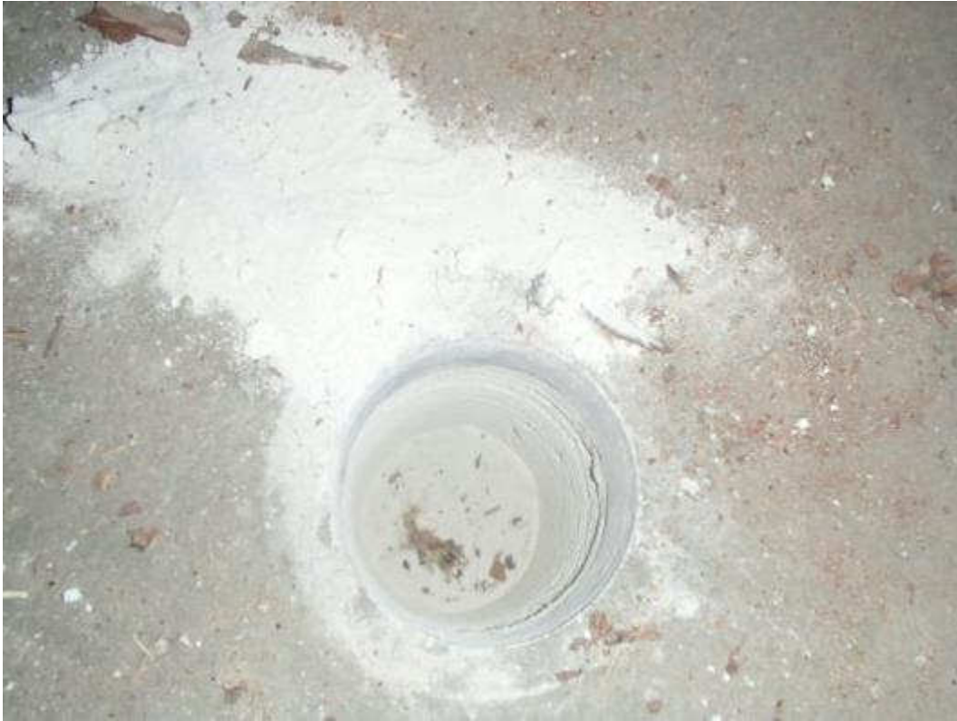
Kuva 23. Rakenneavaus yläpohjarakenteeseen.
