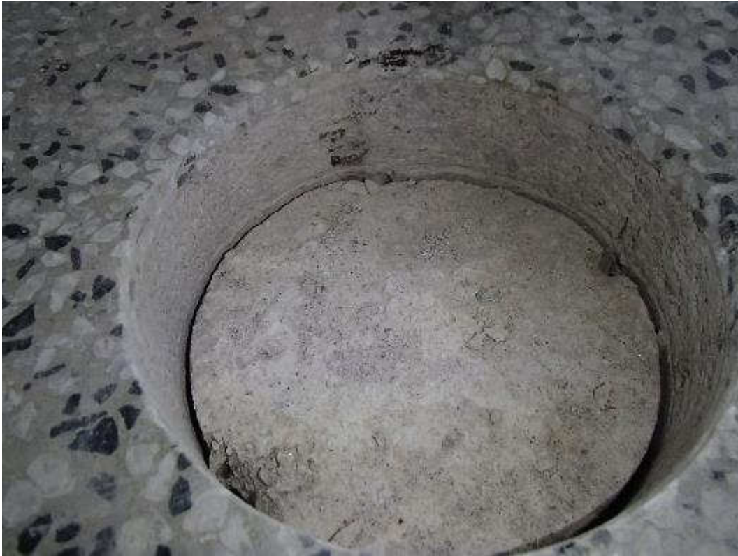
Kuva 49. Rakenneavaus 2.kerroksen käytävän välipohjaan.
