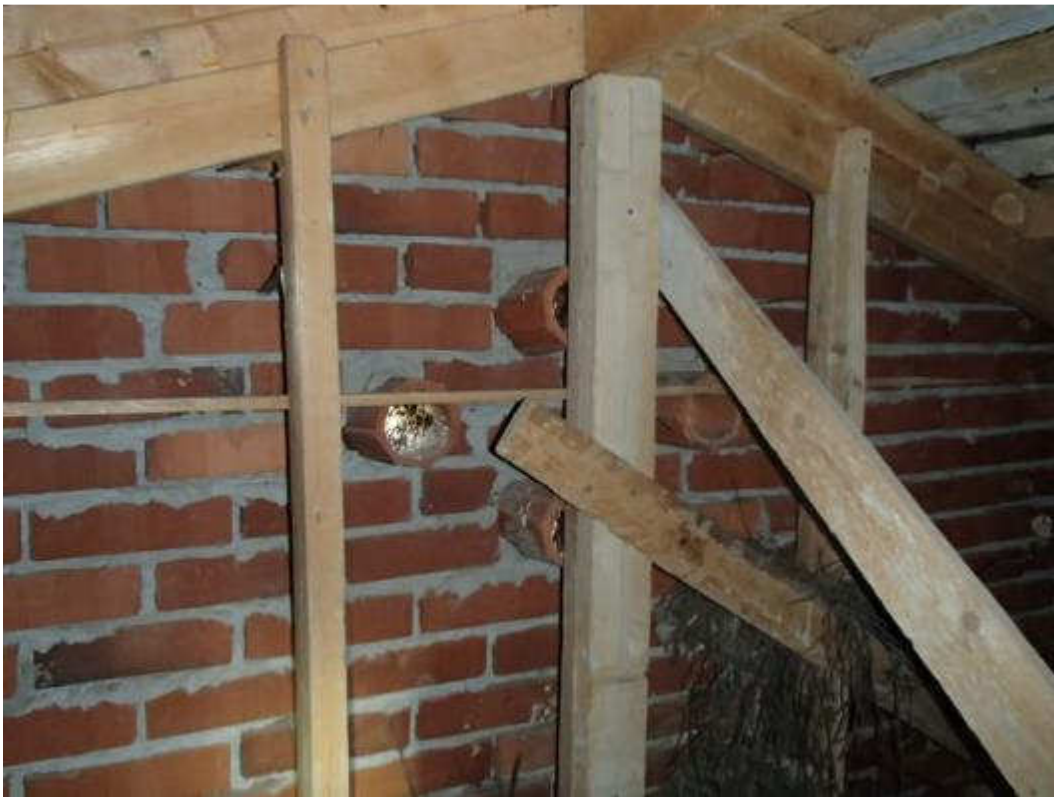
Kuva 97. Yleiskuva tuulettuvasta vinttitilasta.
