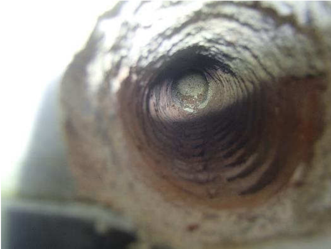
Kuva 5. Rakenneavaus ulkovaipparakenteeseen sisäkautta sokkelin taustalta.
