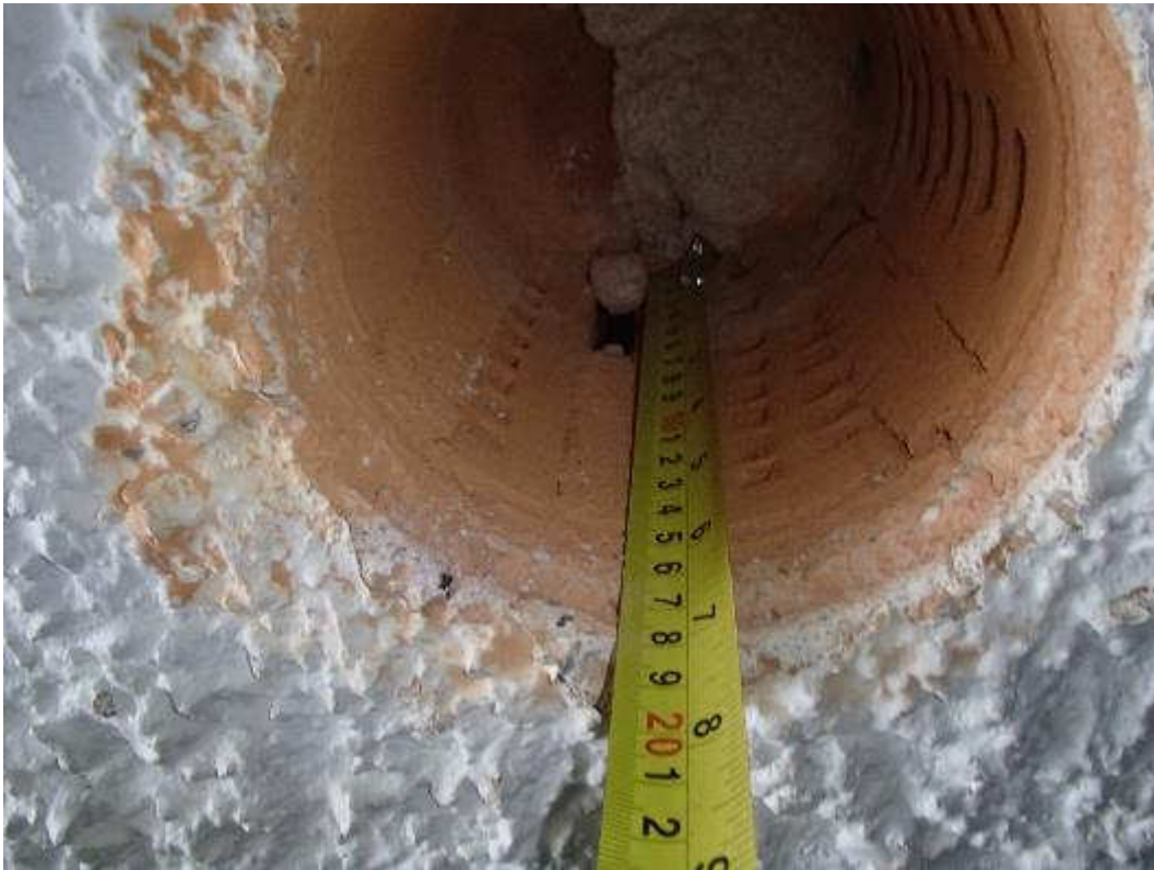
Kuva 2. Rakenneavaus julkisivuun ulkokautta.
