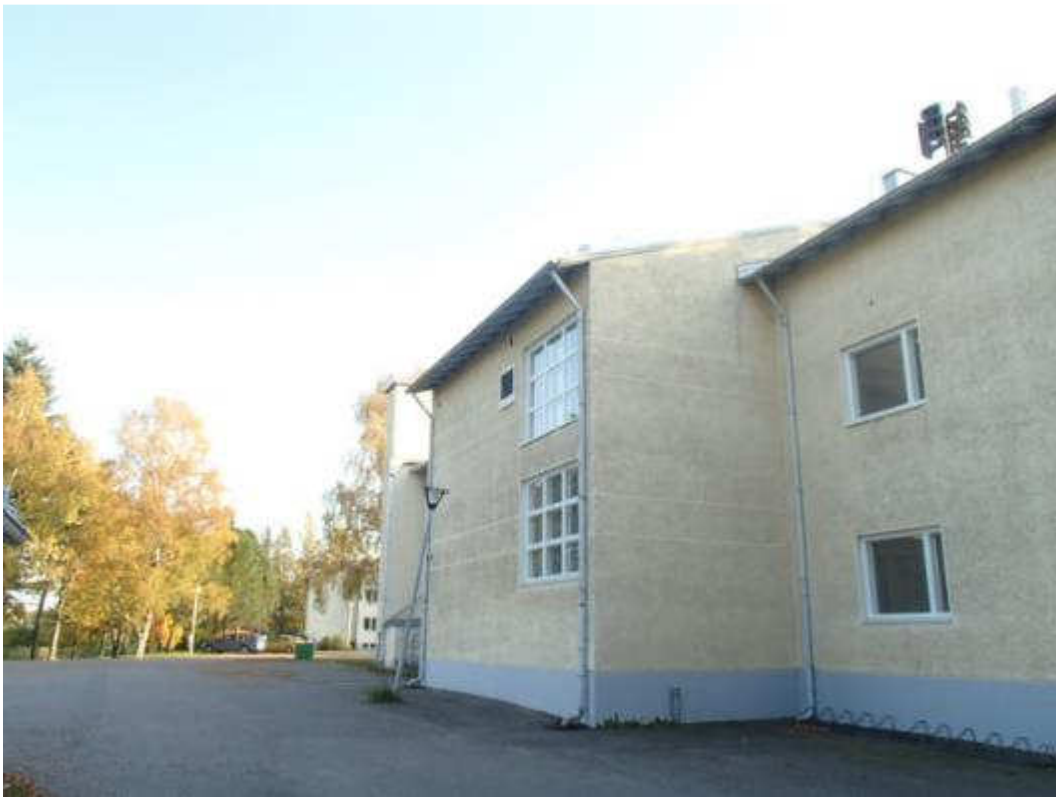
Kuva 18. Rakennuksen sokkelit on kesän aikana pinnoitettu.
