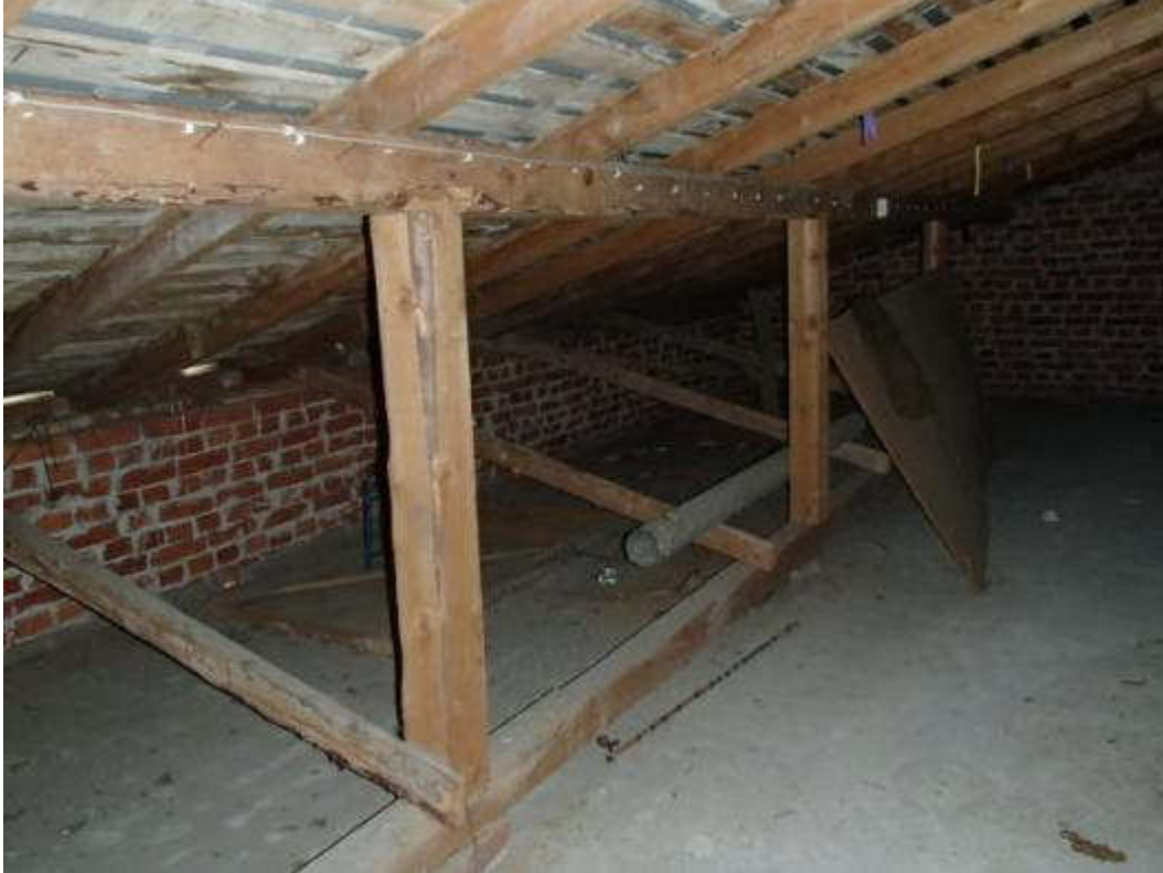
Kuva 22. Yleiskuva tuulettuvasta vintttilasta.
