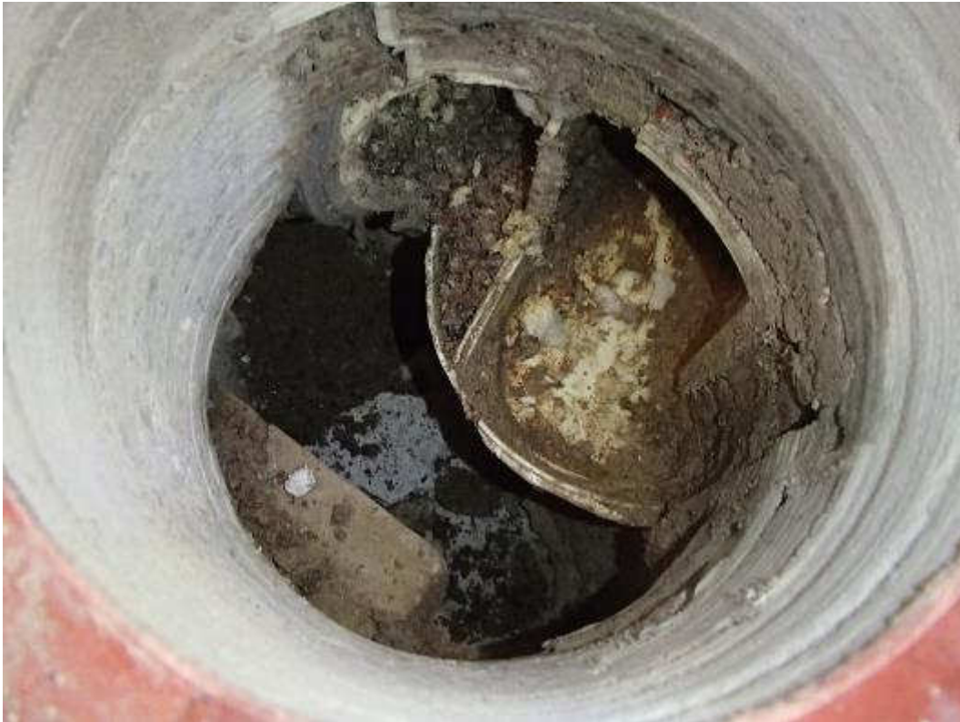
Kuva 40. Rakenneavaus esikoulun välipohjaan entisen suihkutilan kohdalta.
