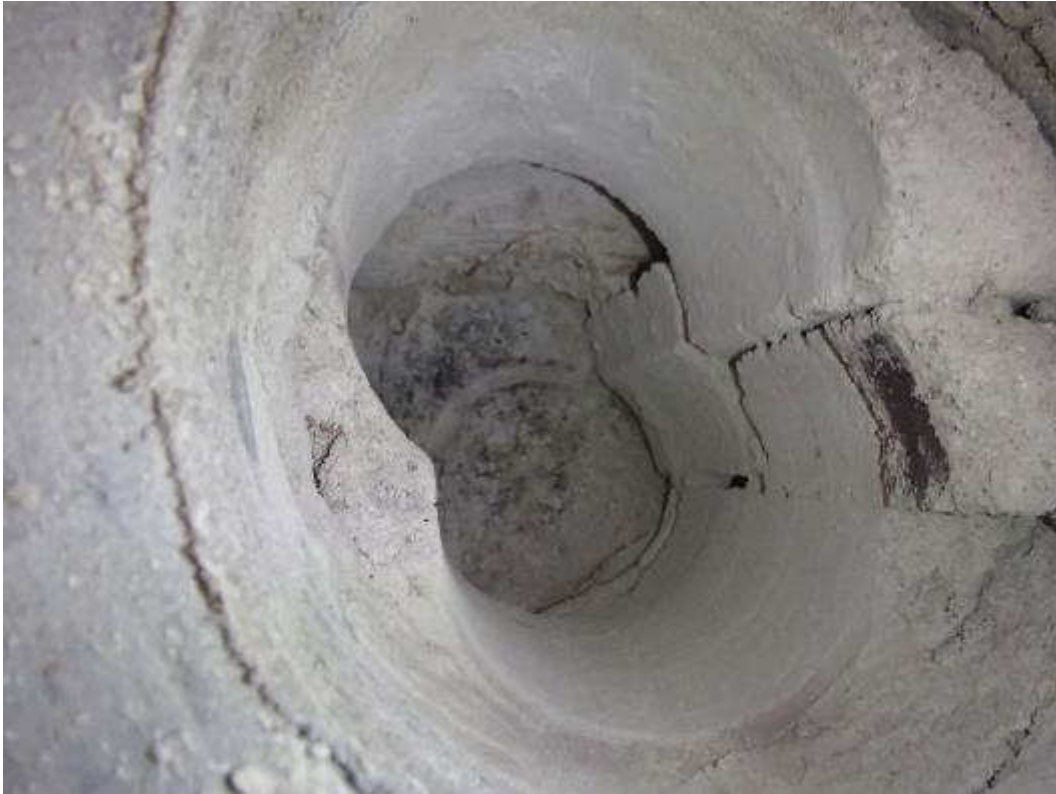
Kuva 60. Rakenneavaus alapohjaan reuna-alueella.
