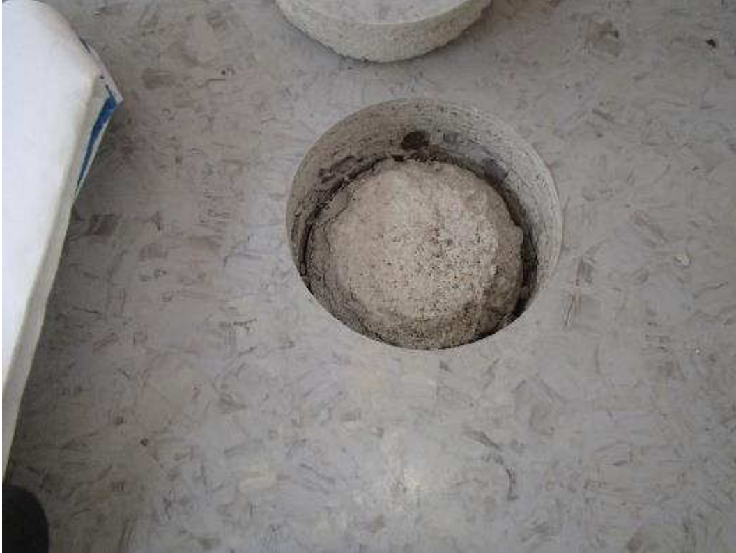
Kuva 50. Rakenneavaus luokan 8 kohdalta välipohjaan.
