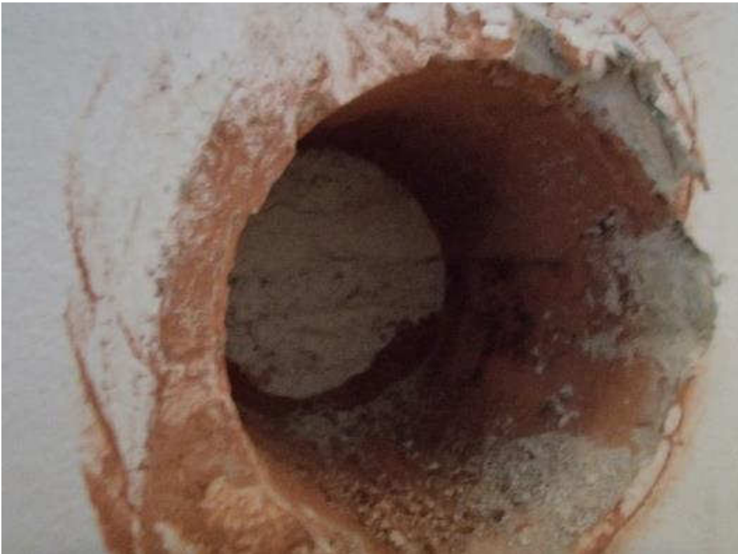
Kuva 4. Rakenneavaus ulkovaipparakenteeseen sisäkautta.
