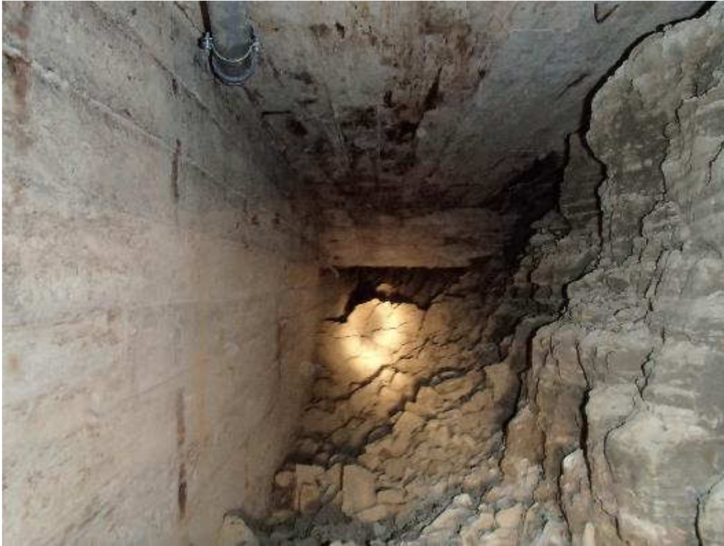
Kuva 68. Yleiskuva opettajienhuoneen alapuoleisesta ryömintätilasta.
