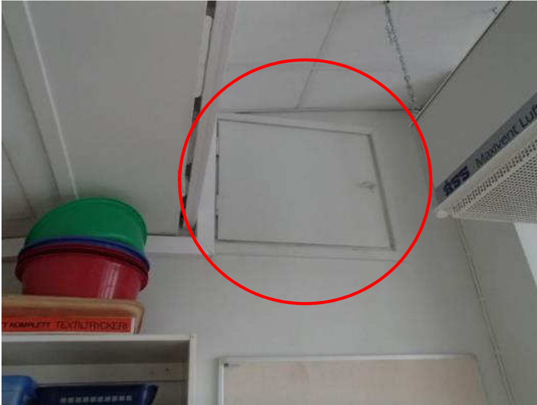
Kuva 34. Vanhan liikuntasalin yläpuoleisesta tuulettuvasta tilasta on suora yhteys tekstiilityöluokkaan.
