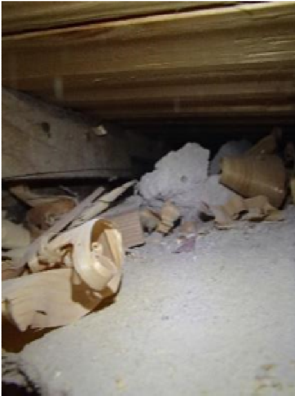
Kuva 46. Rakenneavaus entisen liikuntasalin välipohjaan.
