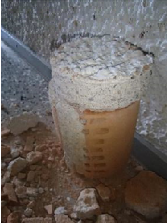
Kuva 3. Rakenneavaus julkisivuun ulkokautta.
