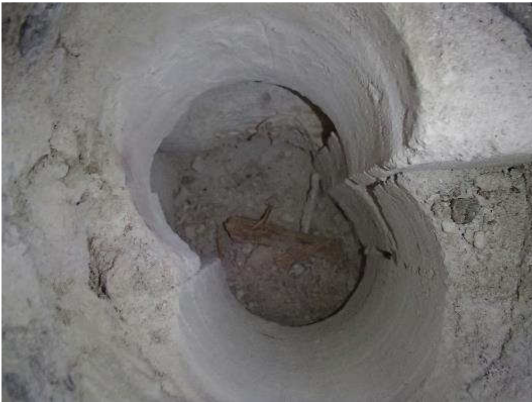
Kuva 67. Alapohjan rakenneavausten yhteydessä kevytbetonieristeen alapuolella havaittiin täytteenä hiekkaa, betonimursketta, puunpalasia ja tiilimursketta.
