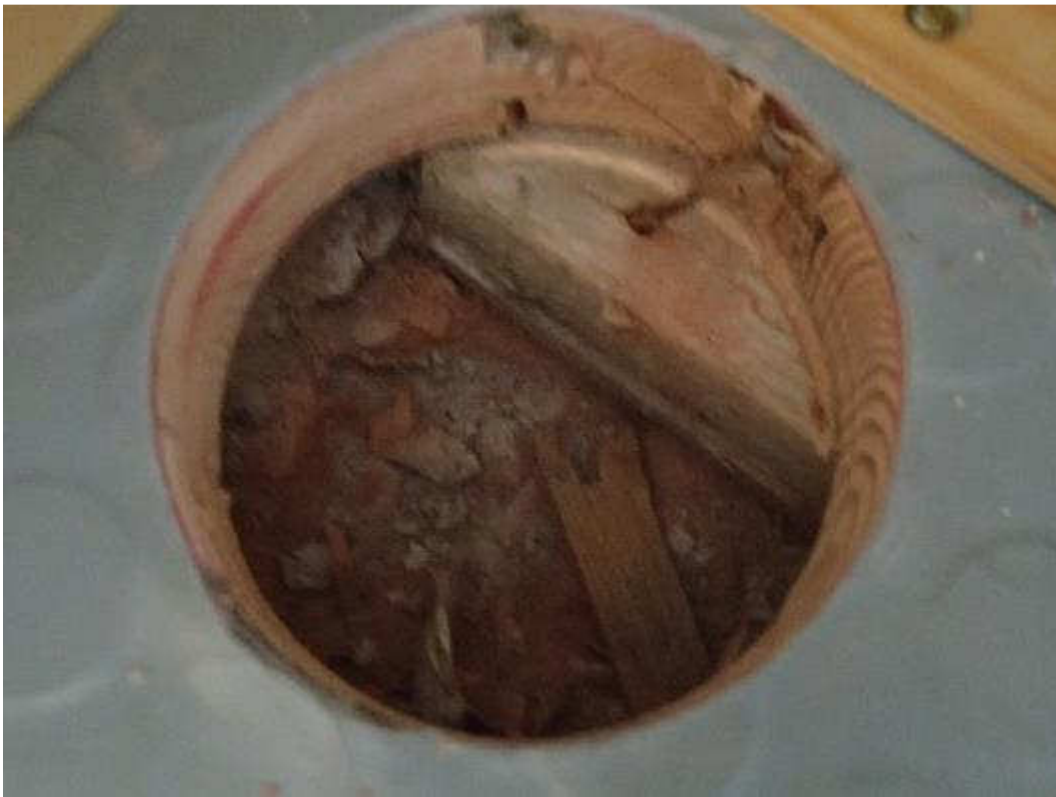
Kuva 54. Puukäsityöluokan lankkulattian alapuolella oli täyttönä paperia, puuta, rivettä ja kaikkea muuta rakennusaikaista roskaa.
