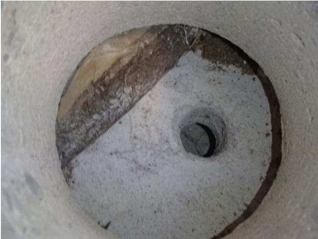
Kuva 43. Rakenneavaus esikoulun välipohjaan entisen pukuhuoneen kohdalta.
