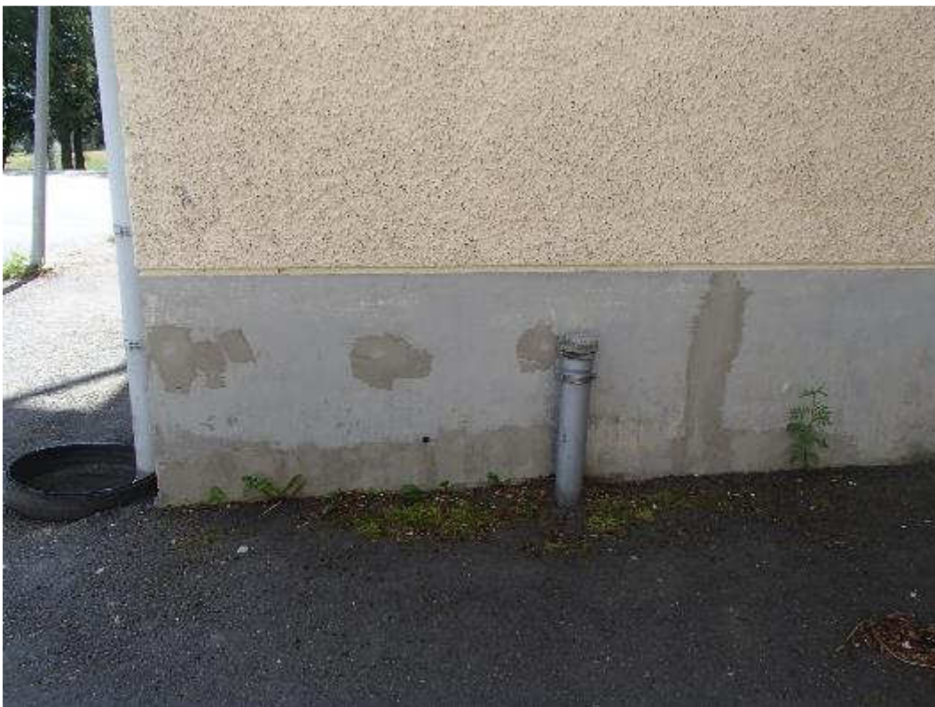
Kuva 16. Sokkelipintojen halkeamia on korjailtu laastilla.
